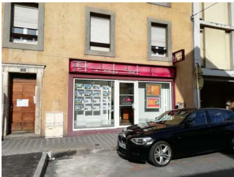
Enseignes en mauvais état, Annemasse, septembre 2019
