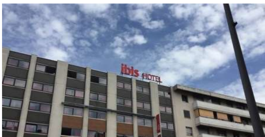
Enseigne sur toiture en lettres découpées, Ambilly, juin 2019
