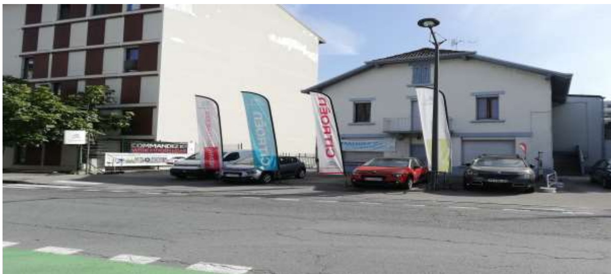
Enseignes installées directement sur le sol en surnombre (une seule par voie autorisée si la surface > 1 m 2 ), Annemasse, septembre 2019
