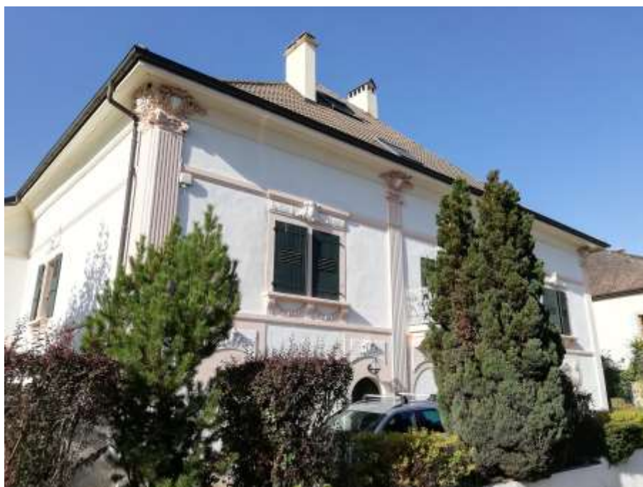
Bâtiment à préserver, Haute-Bonne, septembre 2019
