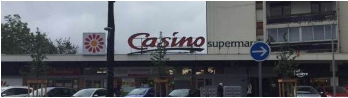
Enseignes sur toiture (non conformes : logo car panneau plein), Gaillard, juin 2019
