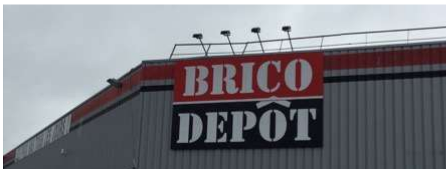
Enseigne lumineuse (éclairage par projection - spots), Vétraz-Monthoux, juin 2019
