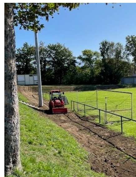
Installation de l'arrosage automatique
