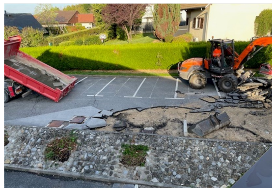
Réfection du parking de la mairie
