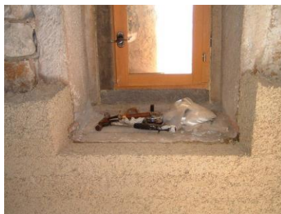
Mur en moellons de pierre avec «correction du rayonnement froid» par un enduit intérieur chaux chanvre
