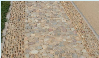
Double calade : une avec galets entiers et l'autre avec galets sciés (confort d'usage)
