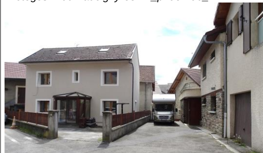
Non protégés, rue du Bief
