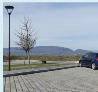
Pavés béton sur les espaces de stationnement - Fillings
