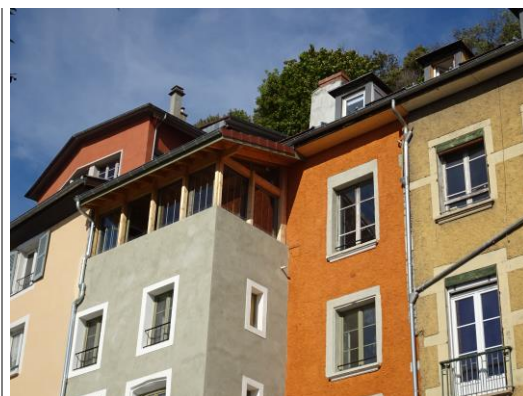
Surélévation traitée comme un couronnement, en structure bois et métal, vitrée sur toute la longueur. La toiture a été reconduite, identique. Grenoble (38) E. Martin-Hernandez archi. Grenoble 38
