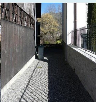
Chemin en gravier – Haute-Bonne place de l'église
