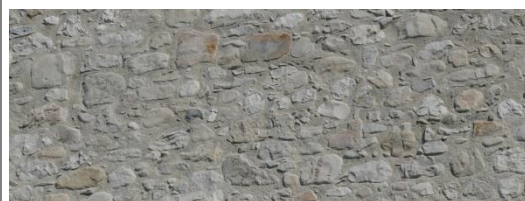
Exemple d'enduit à pierre-vue. L'enduit a une teinte proche des pierres du mur, ce qui rend l'ensemble très cohérent.
