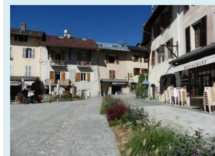
Végétalisation de la rue - Conflans - Albertville
