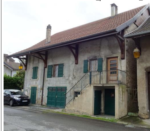
Escaliers extérieurs R Hte Bonne-197_p483_maison de vigneron
