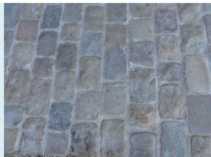
Pavage jointoyé – place de l'église à Haute-Bonne
