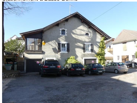
Stationnement de l'ancienne halle commune à Haute-Bonne
