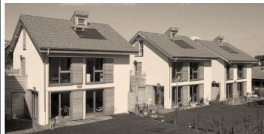
Chavanod 74 Grandes ouvertures, volets coulissants. Atelier Wolf Architectes ©CAUE 74/ Romain Blanchi
