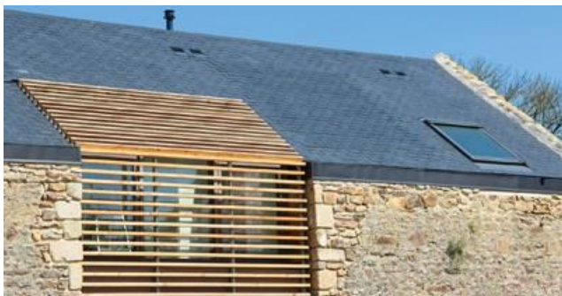
Solaire thermique invisible (sous ardoises) Thermoslate_solar_system
