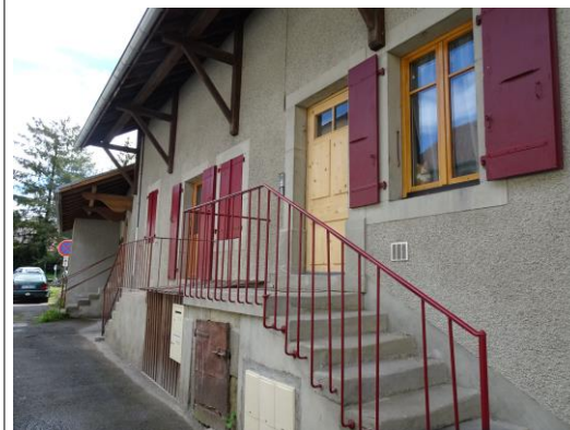
Escaliers extérieurs R du Bief-74_p765-764-763
