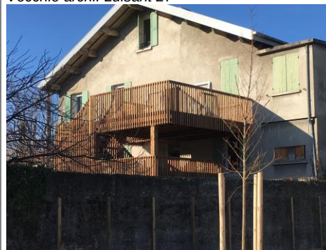
Extension en façade arrière. Bourg-lès-Valence 26
