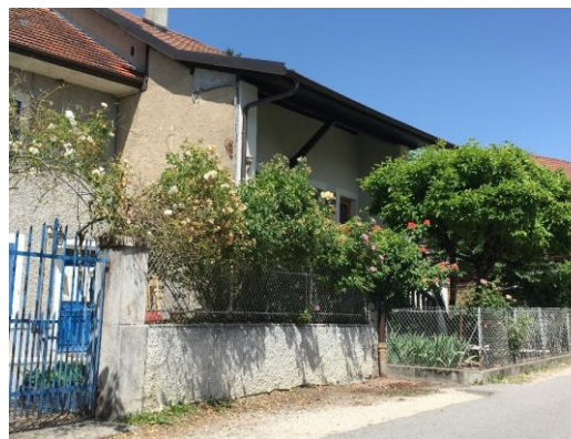
Clôture accompagnée de végétation, transparence du portail
