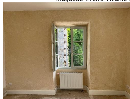
Parement avec finition enduit chaux lissé
