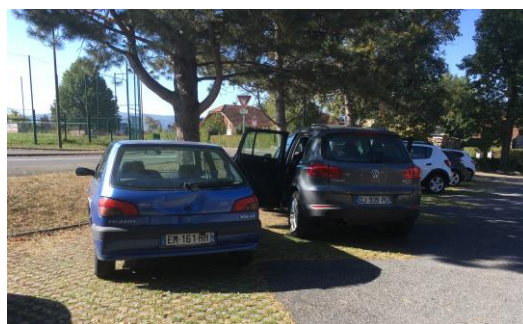
Stationnements perméables de la mairie de Bonne
