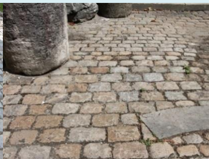
Pavés non jointoyés
