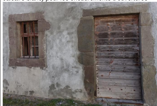
Ici les encadrements sont en pierre molasse, le mur est enduit.
