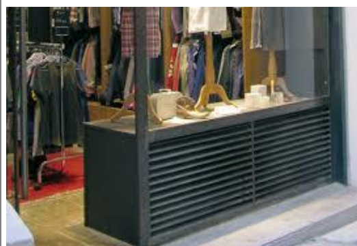
Climatiseurs bien intégrés dans la vitrine
