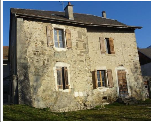
L'enduit usé révèle la structure des murs anciens : pierres locales pour les murs, pierre de taille (ici calcaire blanc) pour les encadrements d'ouvertures
