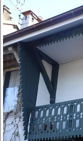
Lambrequins, consoles ouvragées
