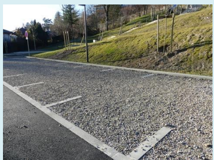
Bonne – Circulation en enrobé et emplacements en stabilisé
