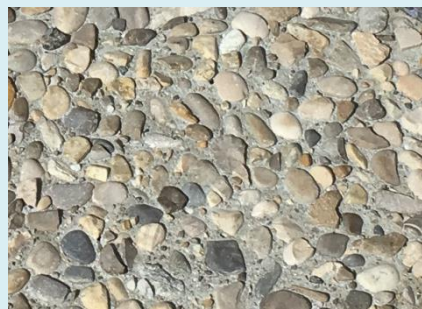
Béton avec petits galets roulés en réinterprétation de la « calade »
