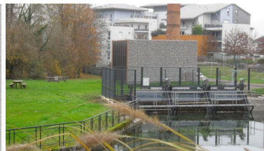
micro-centrale de Cran-Gevrier, sur le Thiou
