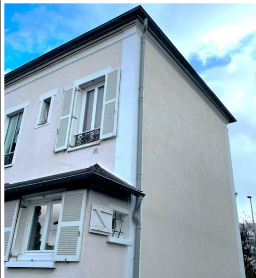
Façade rénovée avec un enduit isolant chaux-liège ©DSD Rénov
